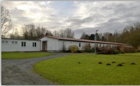
Blick von Nordost auf Haus I und IV
