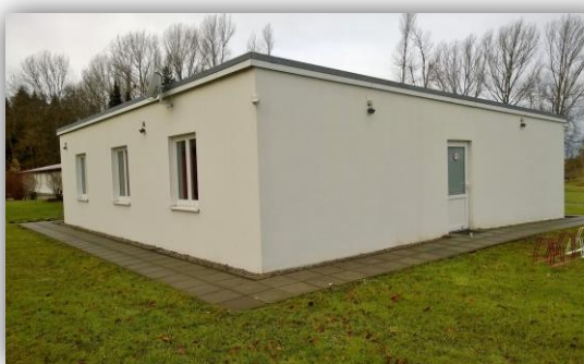
Anbau (Haus IV)
