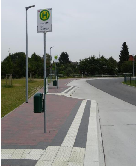
Abbildung 11: Barrierefreie Haltestelle „Pönitz, Schule/ZOB“ mit Hochbord und taktilem Leitsystem
