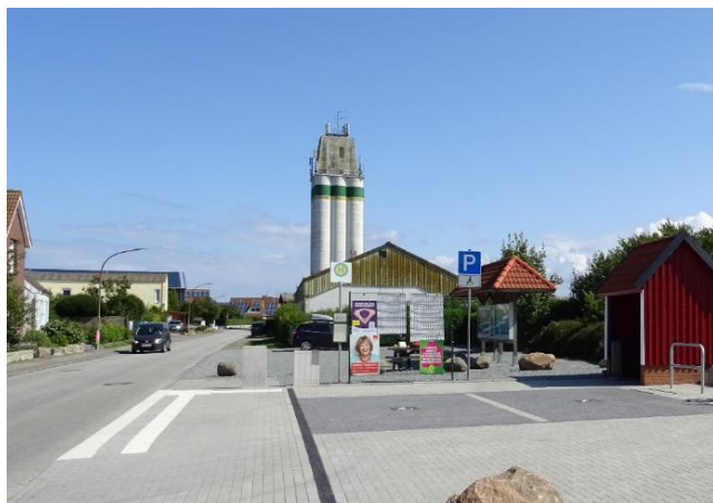
Abbildung 15: Haltestelle „Fehmarn-Petersdorf, Alter Bahnhof“ mit Hochbord und taktilem Leitsystem
