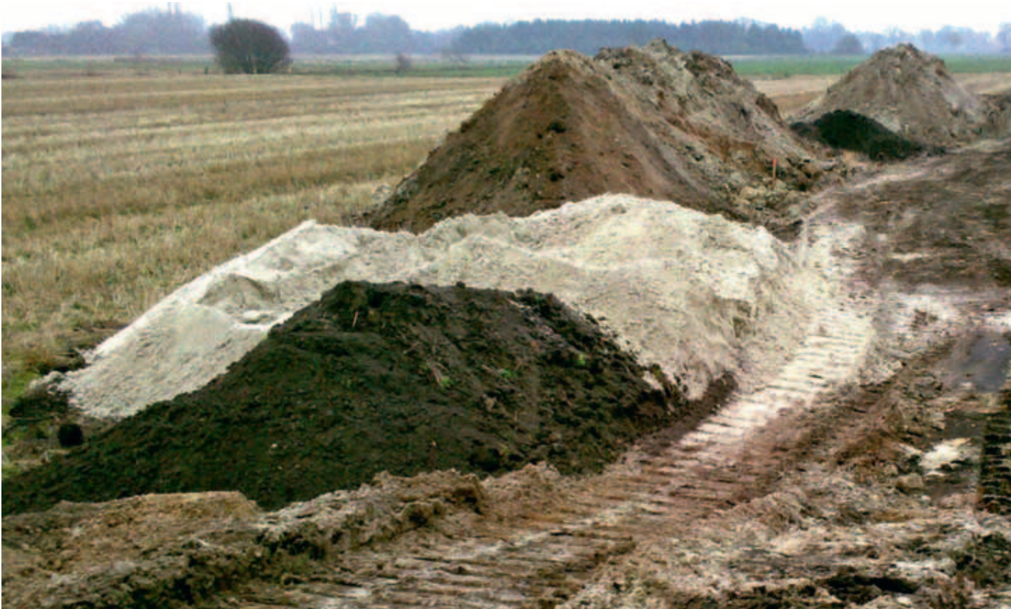
Abbildung 5: Die einzelnen Bodenmieten liegen zu dicht aneinander, so dass Vermischungen beim Wiedereinbau nicht zu vermeiden sind
