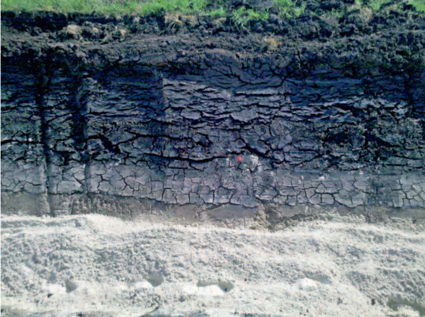
Abbildung 7: Rissbildung und Schrumpfung infolge der Belüftung von Torfen im Leitungsgraben
