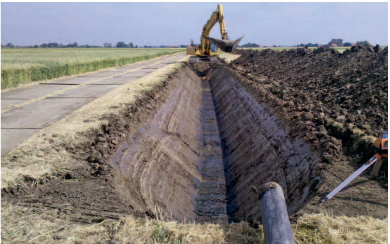
Abbildung 4: Ausheben eines Leitungsgrabens in einer Kalkmarsch
