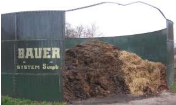
Abbildung 3: Positivbeispiel: Ein ausgedienter Güllebehälter kann als Festmistlager umfunktioniert werden, ein Ablauf für die Jauche zur Vorgrube ist vorhanden.
